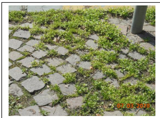
ES. DI PAVIMENTAZIONE DISCONTINUA in PORFIDO CON SOTTOFONDO DI SABBIA
